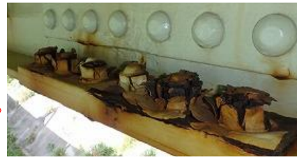
ボルト継手部 腐食弱点部位
