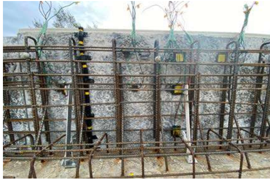
コンクリート打設時に センサ類を埋設
