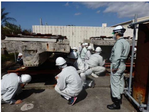
実大鋼桁を用いた実技講習
