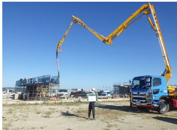
写真 5.1 コンクリート打設状況
