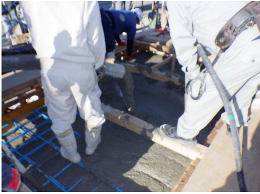
写真 5.5 コンクリート排出状況
