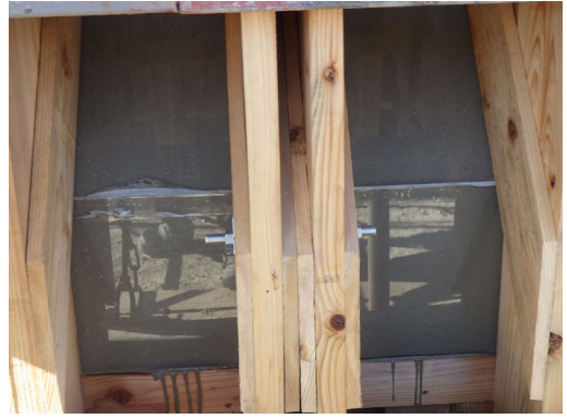
写真 5.6 コンクリート充填状況
