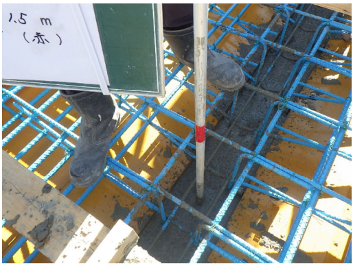
写真 5.7 コンクリート締め固め状況
