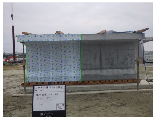
写真5.3 養生テープによる養生日数の延長
