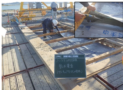
写真5.2 散水養生状況
