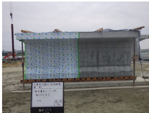
写真1.1 実物大試験体の養生状況
