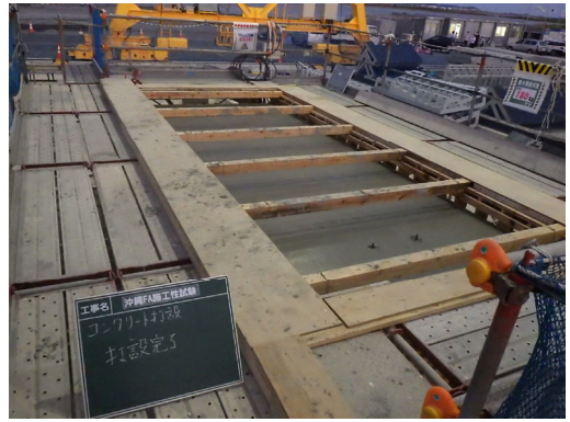
写真 5.8 コンクリート仕上げ状況
